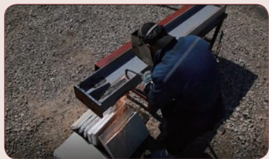
용접·용단 작업 실시
